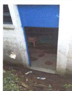
FOTO 6: SUSTITUCION DE CHAPA DE PUERTA DE METAL
