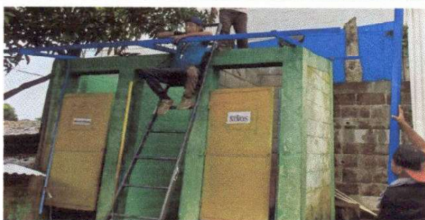
FOTO 3: SUSTITUION DE ESTRUCTURA METALICA Y LAMINA DE BAÑO
