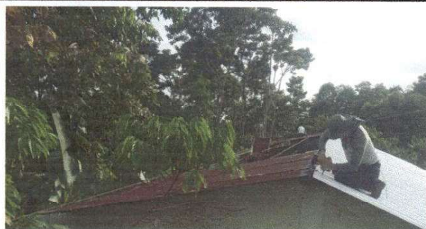
FOTO 1: SUSTITUCION DE LAMINA
