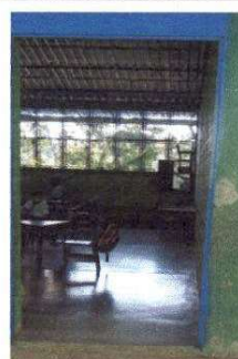
FOTO 4: SUSTITUCION DE 3 PUERTAS DE METAL
